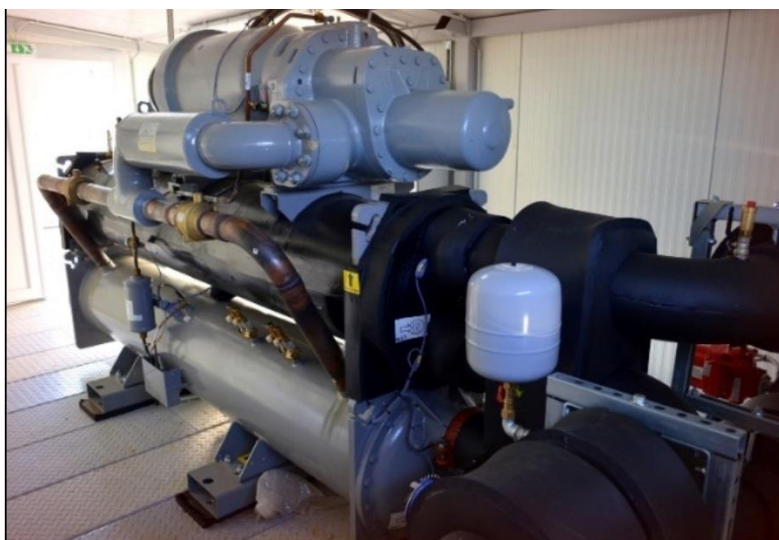
شکل ۳: پمپ حرارتی برای استفاده از گرمای فاضلاب در دانشگاه سیگد (Gyarmati, 2018)
